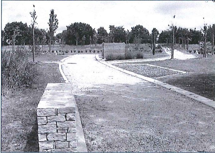
▲ Photo 1 – Allée de cimetière paysager en sablé stabilisé par un liant (La Roche-sur-Yon). Photo : M. Guérin.
